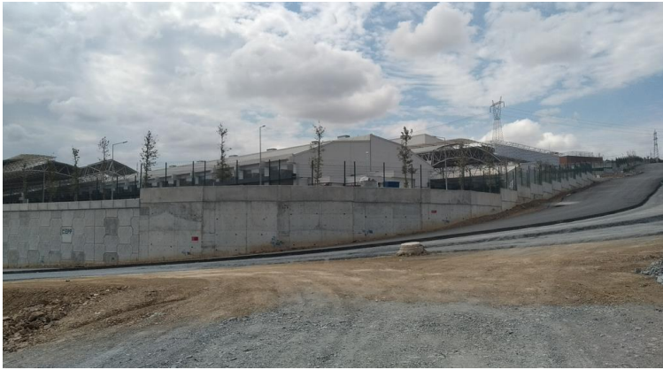
Sahanın güneyinde yeni yapılan inşaat halindeki meyve-sebze hali ve okul
