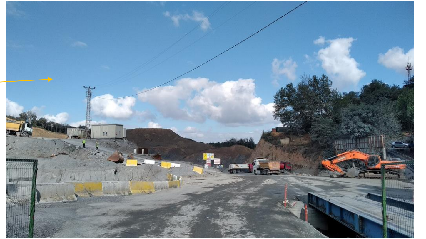
Arnavutköy Taş Ocağı'nın Girişi
