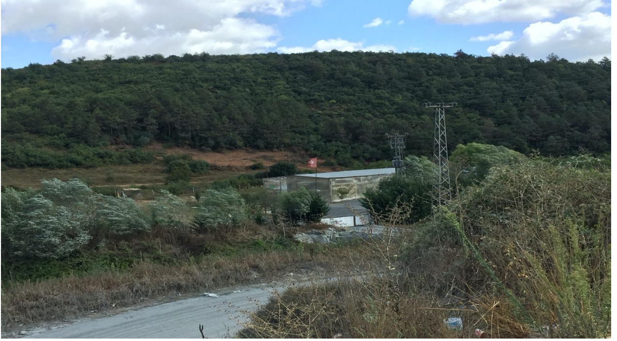
Şekil 2-2 HAKTAŞ Taş Ocağı yakınındaki seranın fotoğrafı
