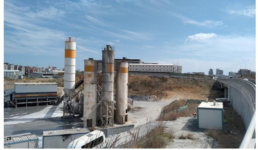
Santral Proje güzergahı içerisinde yer almaktadır.
