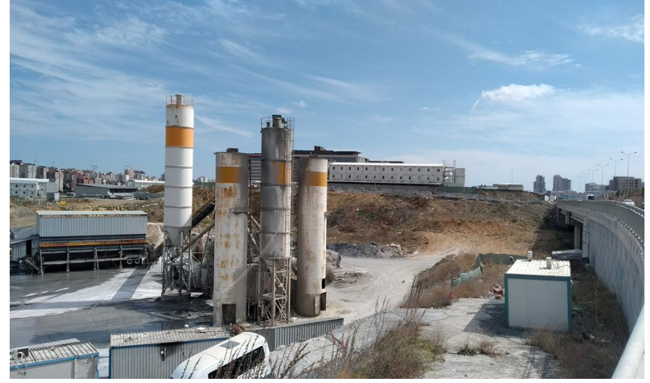
Santral Proje güzergahı içerisinde yer almaktadır.
