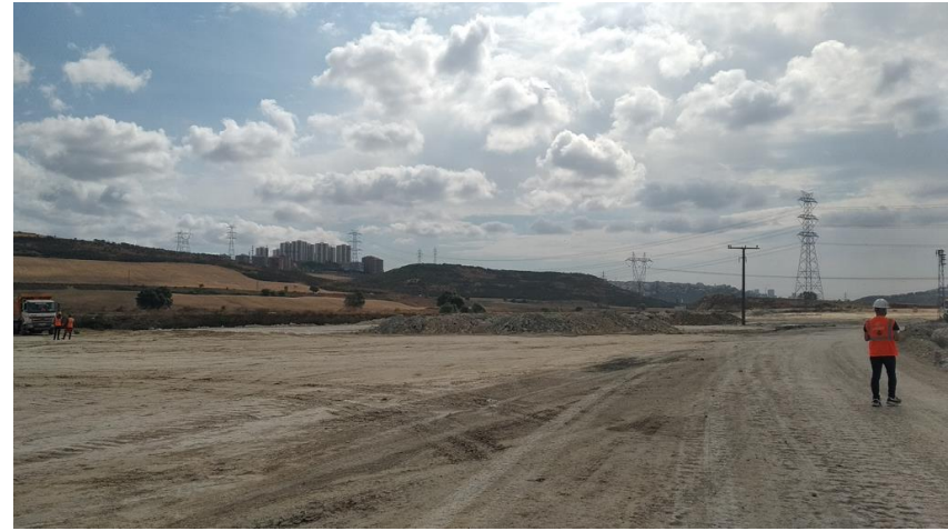
Güneydeki Depolama Alanı
