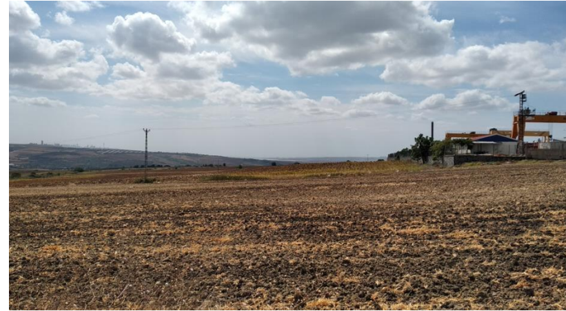
Planlanan inşaat alanı ve yanında prefabrik ünite üretim alanı.
